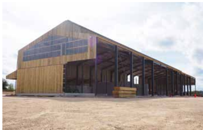
Le séchoir en construction début avril 2024
